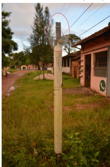
Figura 4: Perfil de trilho utilizado como suporte para varal de roupas.
