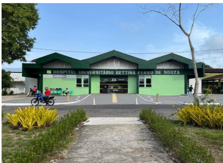
2: Fachada do HUBFS
