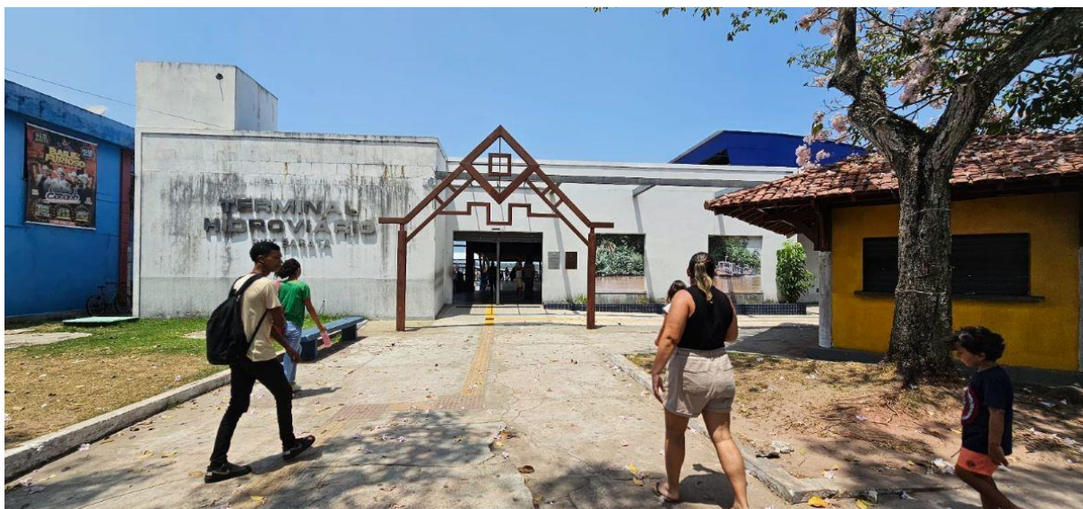
Figura 1. Belém, Pará: Terminal Hidroviário Ruy Barata, porção sul da orla fluvial (fonte: autora, 2024).
