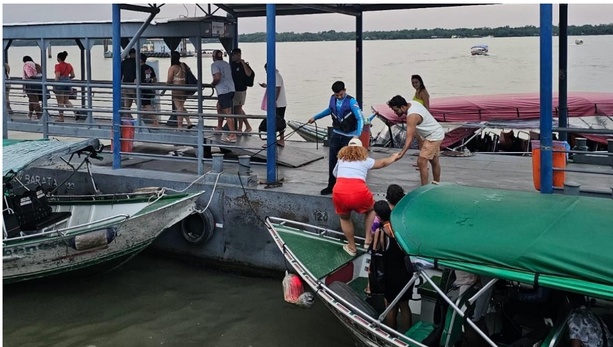
Figura 2. Belém, Pará: Terminal Hidroviário Ruy Barata. Desnível acentuado entre o barco e o flutuante impacta no embarque e desembarque seguro das pessoas (fonte: autora, 2024).
